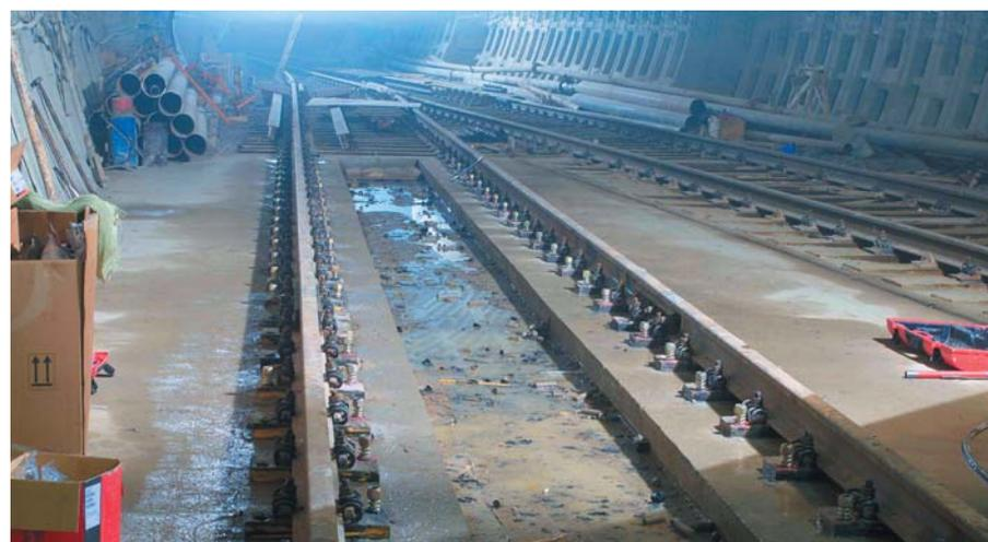
**Рис. 6. Путь на бетонном основании с подкладками на подливочном растворе Icosit, анкерах Hilti. Станция «Международная»**
