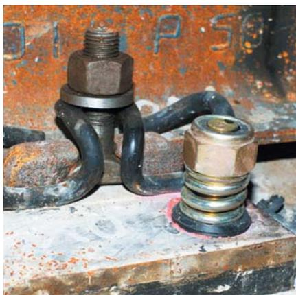
**Рис. 5. Путевая подкладка с анкерами Hilti и упругой клеммой SKL 12-32 Vossloh, установленная на подливочный раствор Icosit**
