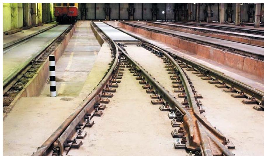
**Рис. 7. Электродепо «Северное». Стрелочный перевод на бетоне**
