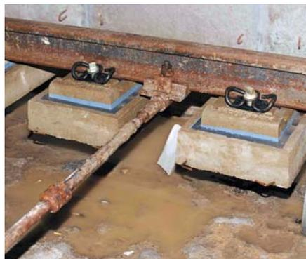
Рис. 2. Подготовленные к монтажу блоки EBS Tines на станции «Международная» Петербургского метрополитена
