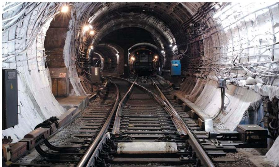
Рис. 4. Стрелочный перевод на деревянных брусках в тоннеле
