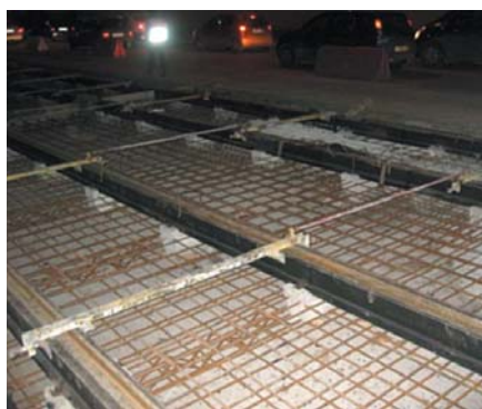
Рис. 1. Заливка бетона в трамвайные пути в Вяземском пер. и на ул. Политехническая
