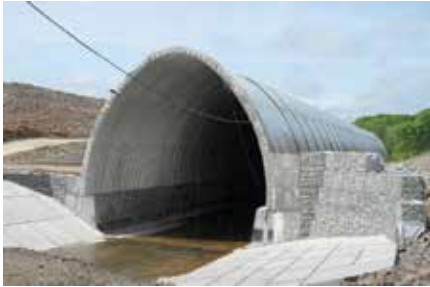
Рис. 2. Металлические гофрированные конструкции обладают высокой прочностью, повышенными сейсмостойкостью и сопротивлением к разрушению
