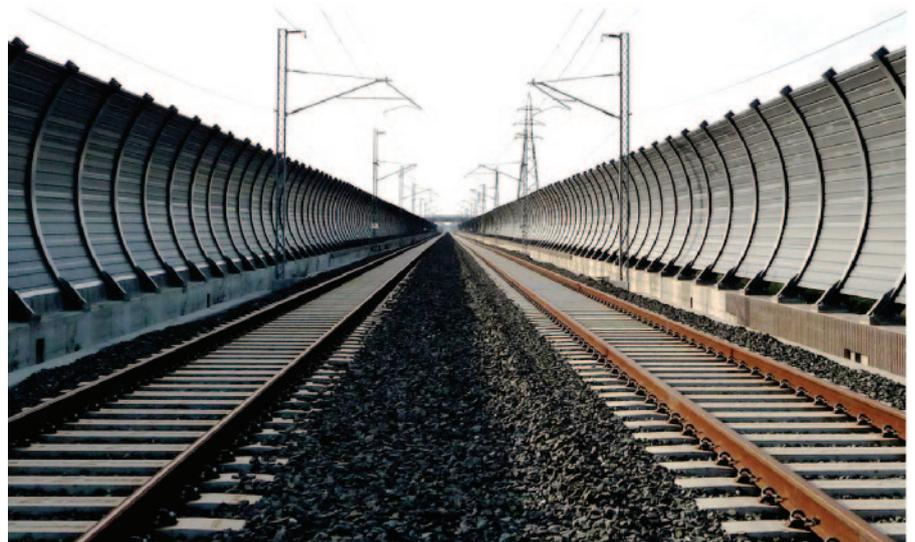
Рис. 3. Шумозащитный экран парусообразной формы по обе стороны железной дороги
