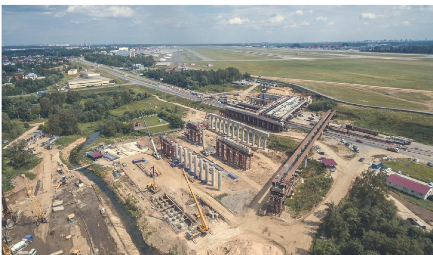
Строительство путепровода через Шереметьевское шоссе (Аэропорт Шереметьево ВПП-3)
