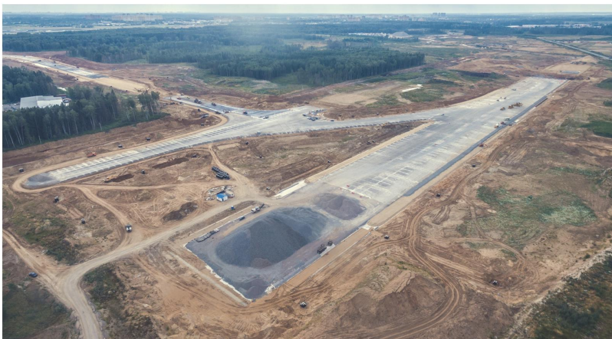
Строительство ВПП-3, РД-Д, РД-Е, РД-Е3 (Аэропорт Шереметьево ВПП-3)
