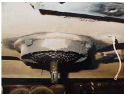
Рис. 5. Подпятник со стальной прокладкой.
