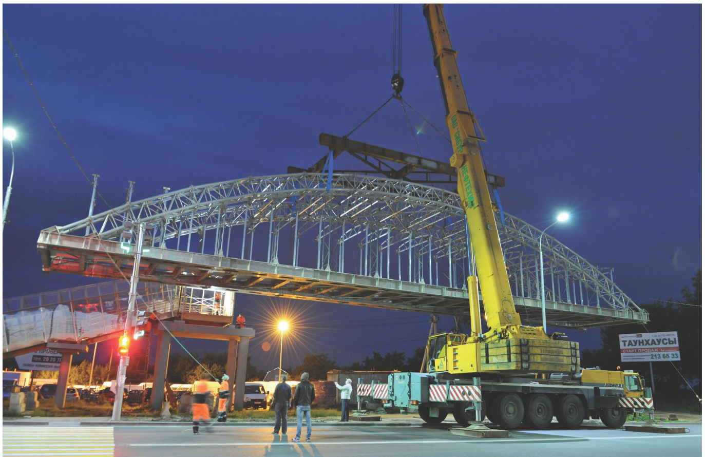
Монтаж пешеходного моста в дер. Афоново (Нижегородская область, 2017 г.)
