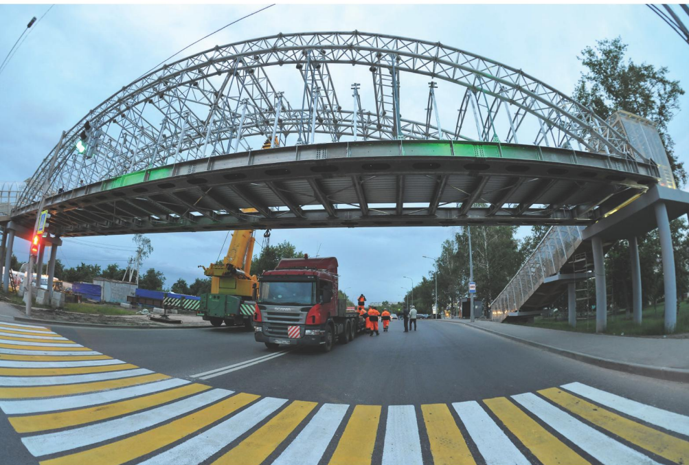
Пешеходный алюминиевый мост в дер. Афоново (Нижегородская область, 2017 г.)
