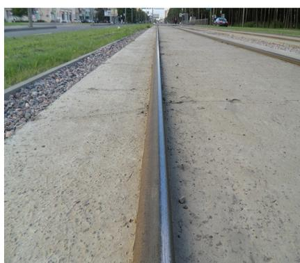
Рис. 13. Пятно контакта на монолитной конструкции без подуклонки
