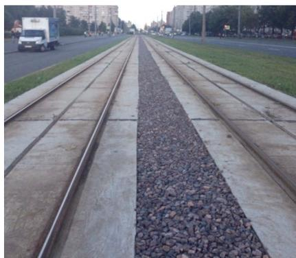
Рис. 12. Проспект Ветеранов: вода эффективно отводится с поверхности плиты
