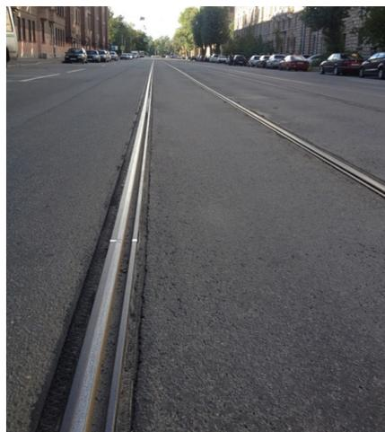
Рис. 4. Вяземский переулоч, монолитное основание
