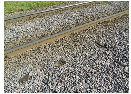
Рис. 6. Пискаревский проспект, конструкция на шпалах: деревянные шпалы выходят из строя менее чем за 10 лет службы
