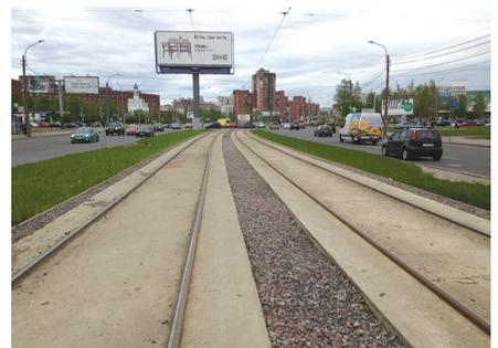
Рис. 8. Тихорецкий проспект, конструкция на монолитном основании
