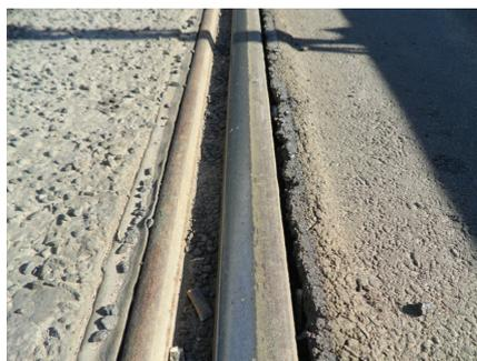
Рис. 5 Пискаревский проспект, конструкция на шпалах: вспучивание асфальтобетона
