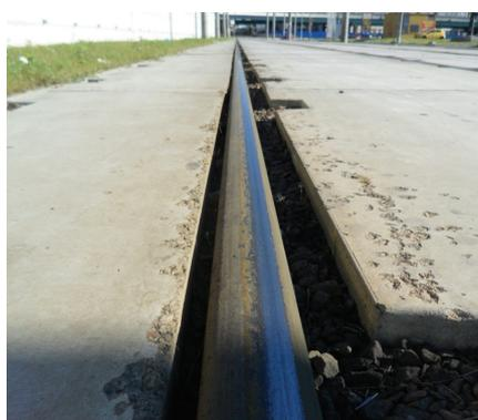
Рис. 14. Пятно контакта на конструкции на шпалах с подуклонкой
