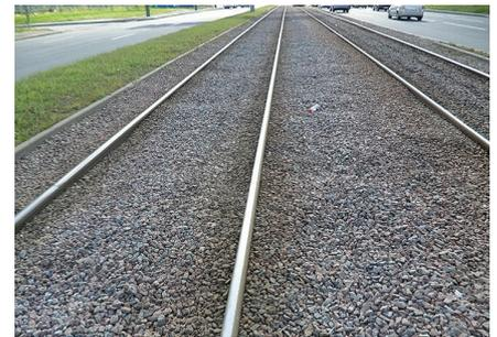
Рис.7. Дальневосточный проспект, конструкция на шпалах: балласт засорен, его верхний слой разрушен
